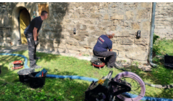
Einspritzen des Harzes in die Hohlräume unter der Kirche Foto: Friedrich Bürglen
